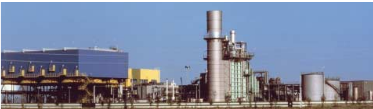
Fig. 13 - Vista da nord-est della Centrale termoelettrica di San Quirico
