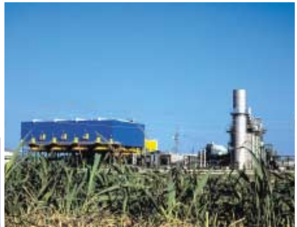
Fig. 1 - Centrale termoelettrica di San Quirico
